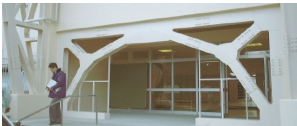
下：鉄骨ブレースの完成状況
