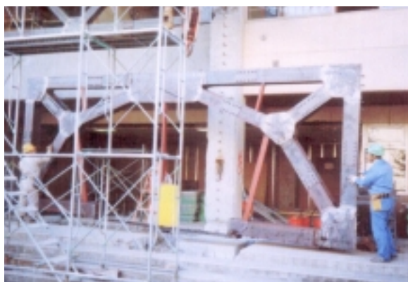
左：鉄骨ブレースの吊込み作業
